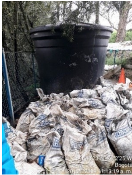
Fotografía No. 3 Sedimentador – Almacenamiento de Lodos
